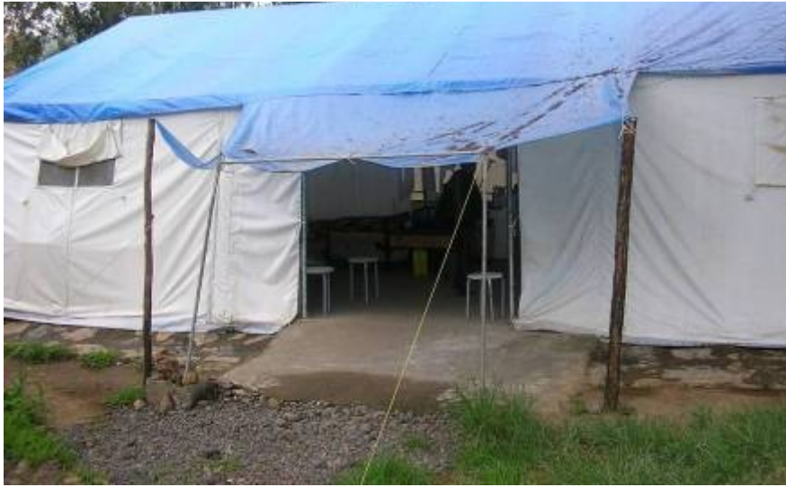
Gondar, Centro de ensaios clínicos antes da reabilitação
